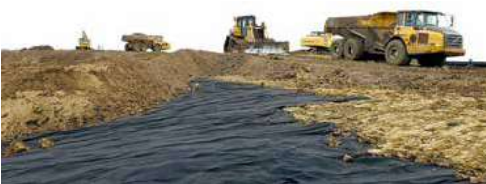
Travaux de couverture
