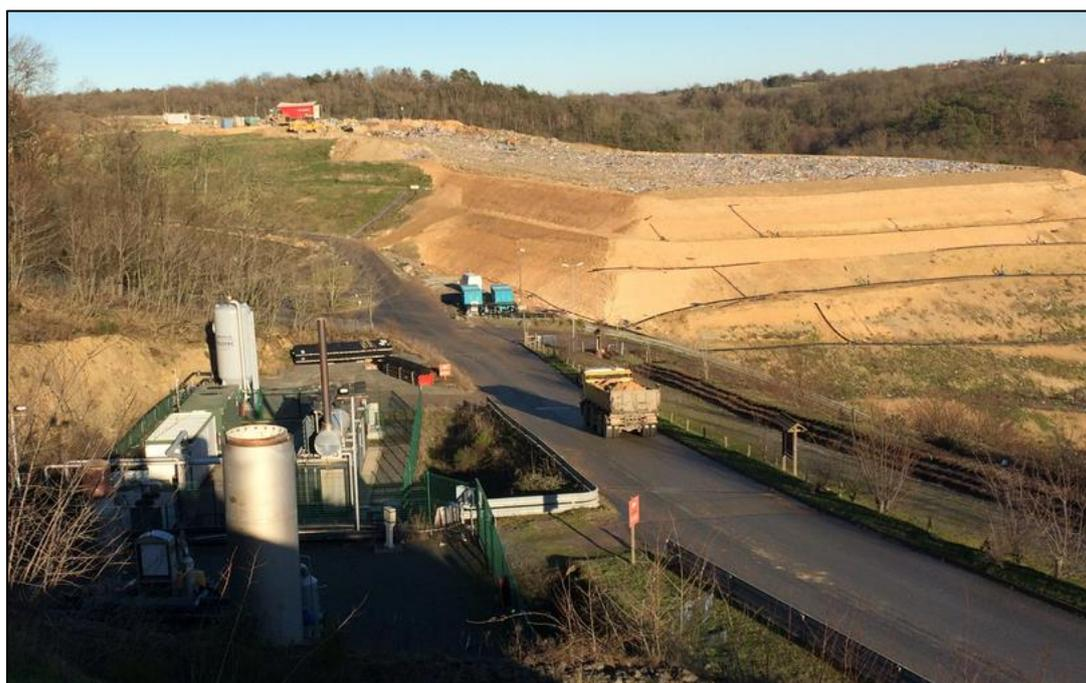
Figure 46 : Les deux torchères et le moteur de valorisation en bas à gauche, casier en haut à droite
