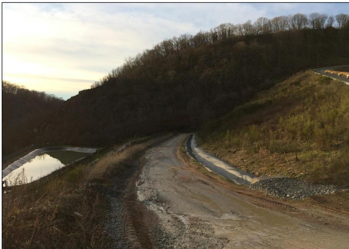
Figure 25 : Ouvrage de gestion des eaux pluviales au sud du site
