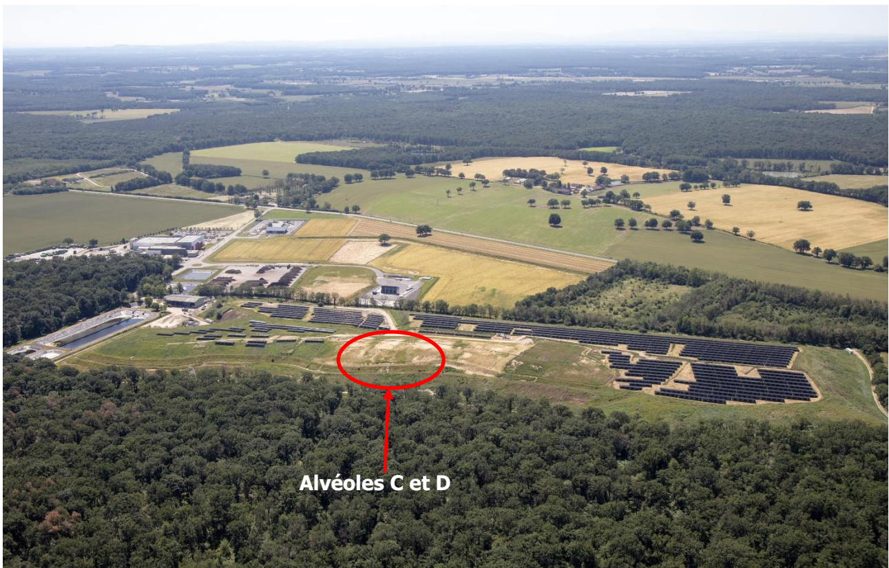
Photo aérienne du 3 juin 2020 : emprise des dernières alvéoles réaménagées C et D
